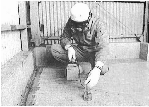
写真-8 研削後の残存汚染測定
