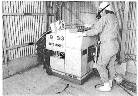
写真-7 コンクリート床面の研削除染
