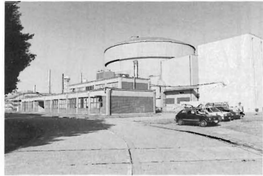
写真-1 JRR-3 外観
