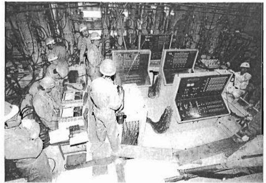
写真-6 センターホールジャッキ操作状況
